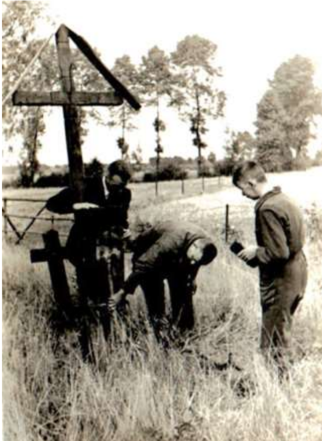
FOTO 1937 Halse Barrier 0 (4).jpg
